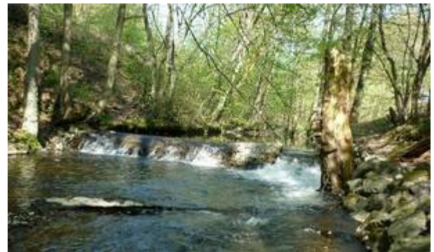
Reste des Wehrs der ehemaligen Lumpenmühle zwischen Lorsbach und Eppstein
